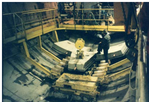
Slika 15. Postavljanje stroja u početno okno na gradilištu u Milanu; prikaz stražnjeg dijela stroja s podizačem kojim se segmenti postavljaju u prstenove segmentne obloge [7]
