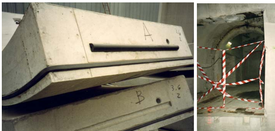
Slika 12. Povoljno rješenje segmenata s rubnim zakošenjima te prikaz mjesta na kojem je segmentna obloga izrezana da bi se dobilo poprečno okno [7]
