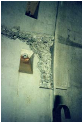
Slika 10. Pojava pukotina na rubnim dijelovima segmentne obloge nakon montaže segmenata te uzdužna reška poboljšana ugradnjom čeličnih ploča [7]
